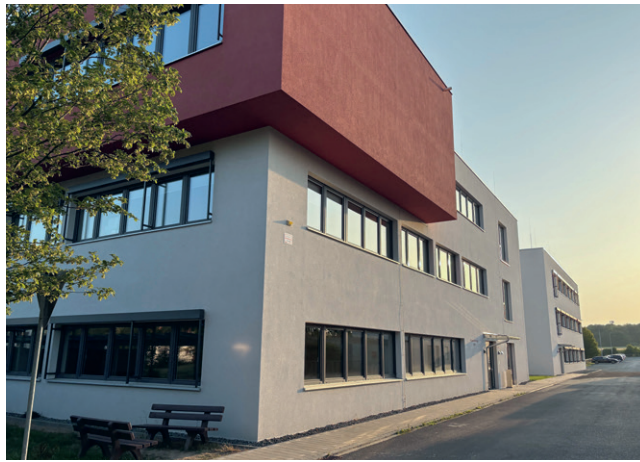
FAU Lehrgebäude am MCO in Bayreuth
